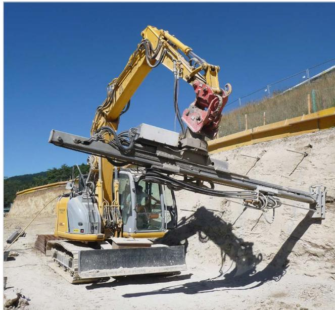
Exaktes Ausrichten der Anbaulafette am Bohransatzpunkt.
