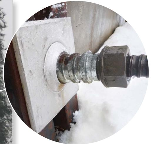
Einfache visuelle Kontrolle der Verformungen ohne geodätische Vermessung.
