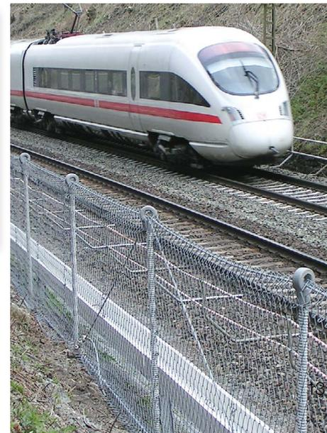
Gleisabspernung mit Steinschlagschutznetz bestehend aus ISCHEBECK-Traggliedern, Ankerkopföse TITAN für das Topseil und Drahtösen TITAN für die Mittelseile.
