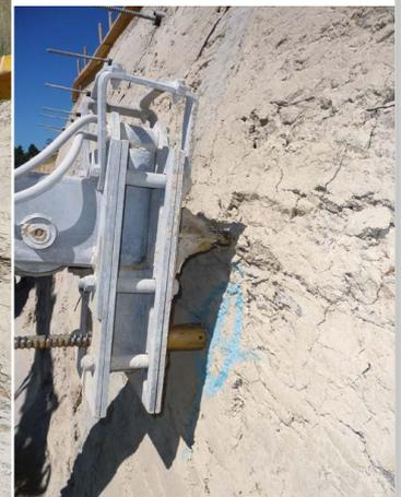
Lagenweiser Aushub und Sicherung der Abschlagshöhe in Abhängigkeit der Standfestigkeit des anstehenden Bodens (i.d.R. ca. 1 – 2 m). Sobald die Rückverankerung und die Spritzbetonschale einer Lage ausgehärtet sind, erfolgt der nächste Aushub.
