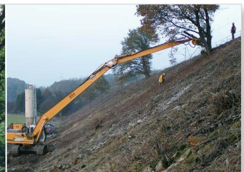
Da der über Jahrzehnte natürlich gewachsene Bewuchs üblicherweise nicht zerstört werden soll und die Hänge ohnehin empfindlich gegenüber zusätzlichen Belastungen sind, erfolgen die Sicherungsarbeiten meist von der Dammkrone oder vom Dammfuß aus.
