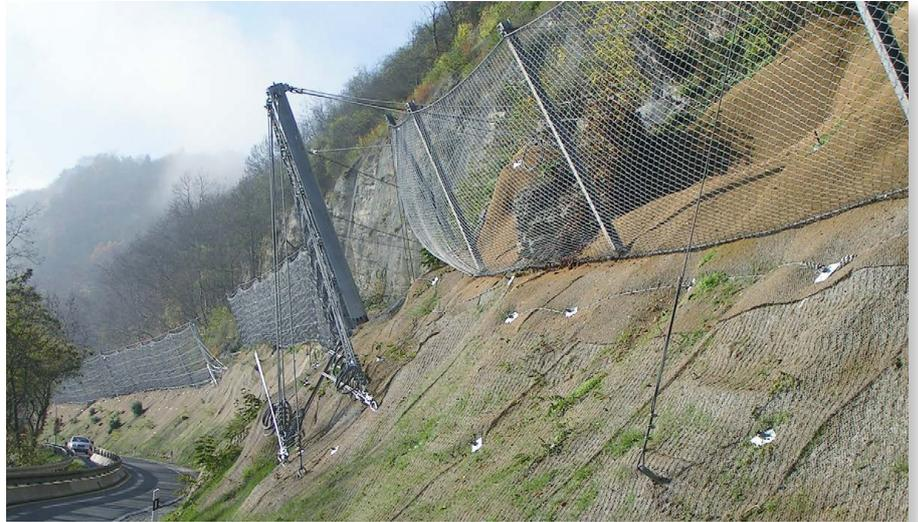
Hierbei müssen einmal die gelenkigen Grundplatten verdrehsicher gegründet werden, was i.d.R. über einen Pfahlbock, bestehend aus zwei axial belasteten Mikropfählen, geschieht.
