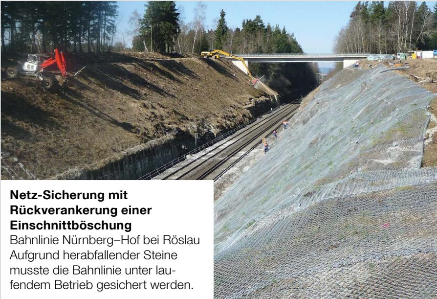
**Netz-Sicherung mit Rückverankerung einer Einschnittböschung**
