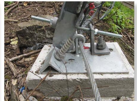
Darüber hinaus werden die Zäune parallel und senkrecht zur Zaunrichtung über Drahtseile abgespannt. Um zu verhindern, dass der hier verwendete Mikropfahl Querkräfte aufnehmen muss, wird meist eine flexible Seilöse (Flexkopf, kein Bestandteil des ISCHEBECK Lieferprogramms) verwendet, die auf den Mikropfahl TITAN aufgeschraubt werden kann.
